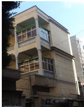
لوحة رقم (3) الواجهة الجنوبية الغربية. (تصوير الباحث)
