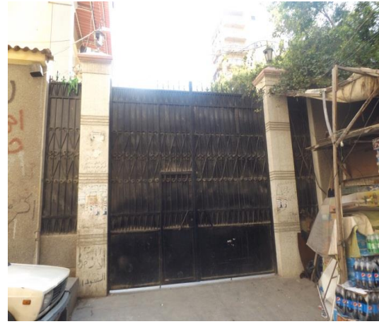
لوحة رقم (6) البوابة الثانية بالواجهة الشمالية الغربية. (تصوير الباحث)
