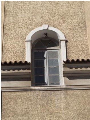
لوحة رقم (17) نافذة عبارة عن دخلة معقودة بعقد نصف دائري عريض بواجهة المبنى الشمالي الغربي للفناء . (تصوير الباحث)
