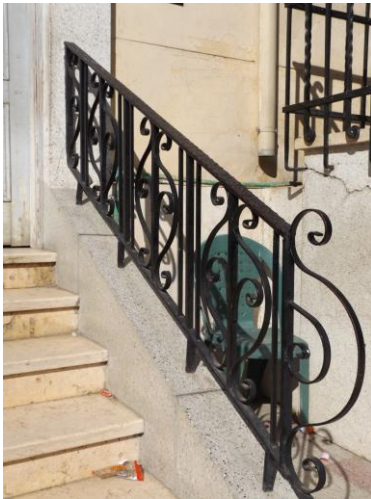
لوحة رقم (13) درابزين سلم معدني مزخرف بمشكبات معدنية ذات نهايات حلزونية على شكل حرف S باللاتينية (تصوير الباحث)
