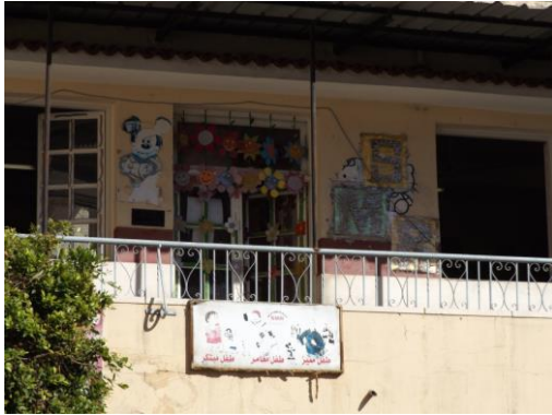
لوحة رقم (11) شرفة بالطابق الأول بالمبنى الشمالي الشرقي للفتاء يتقدمها سور مقسم من خلال أسياخ الحديد تظهر به زخرفة الكلاب المتلاحقة. (تصوير الباحث)
