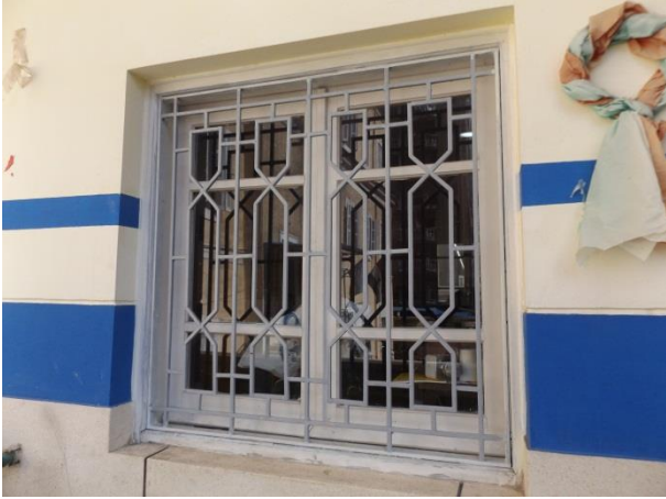
لوحة رقم (23) نافذة مستطيلة يغلق عليها من الداخل درفتين من الخشب ومن الخارج يغلق عليها أشغال الحديد. (تصوير الباحث)
