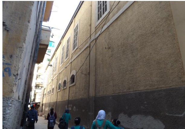
لوحة رقم (32) الواجهة الشمالية الشرقية لمدرسة سان ميشيل. (تصوير الباحث)
