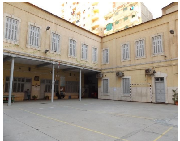
لوحة رقم (38) فناء المدرسة والمبنيين الجنوبي الشرقي والشمالي الشرقي على شكل حرف L. (تصوير الباحث)
