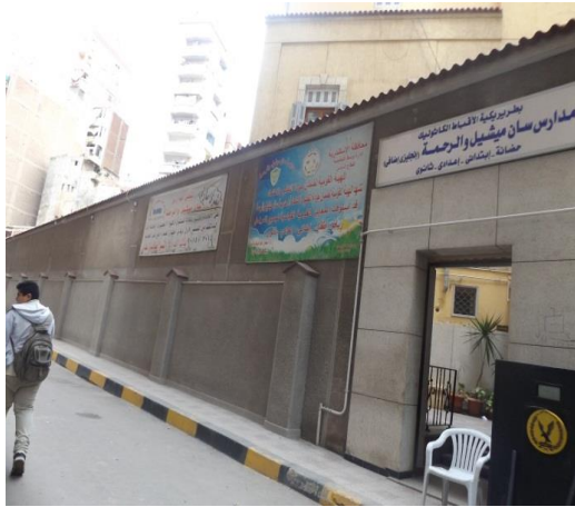
لوحة رقم (37) السور الخارجي ومدخل المدرسة بالطرف الجنوبي من الجهة الجنوبية الغربية. (تصوير الباحث)
