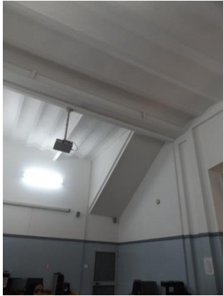
لوحة رقم (49) سقف معمل الحاسب الآلي على شكل كمرات مستطيلة بارزة. (تصوير الباحث)
