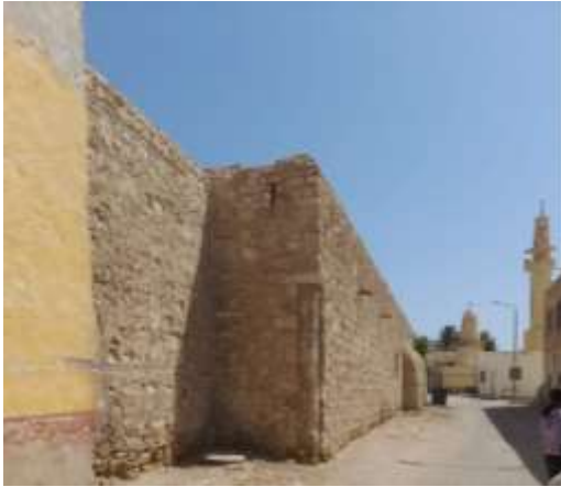
لوحة (٢) الواجهة القبليّة (تصوير الباحث)
